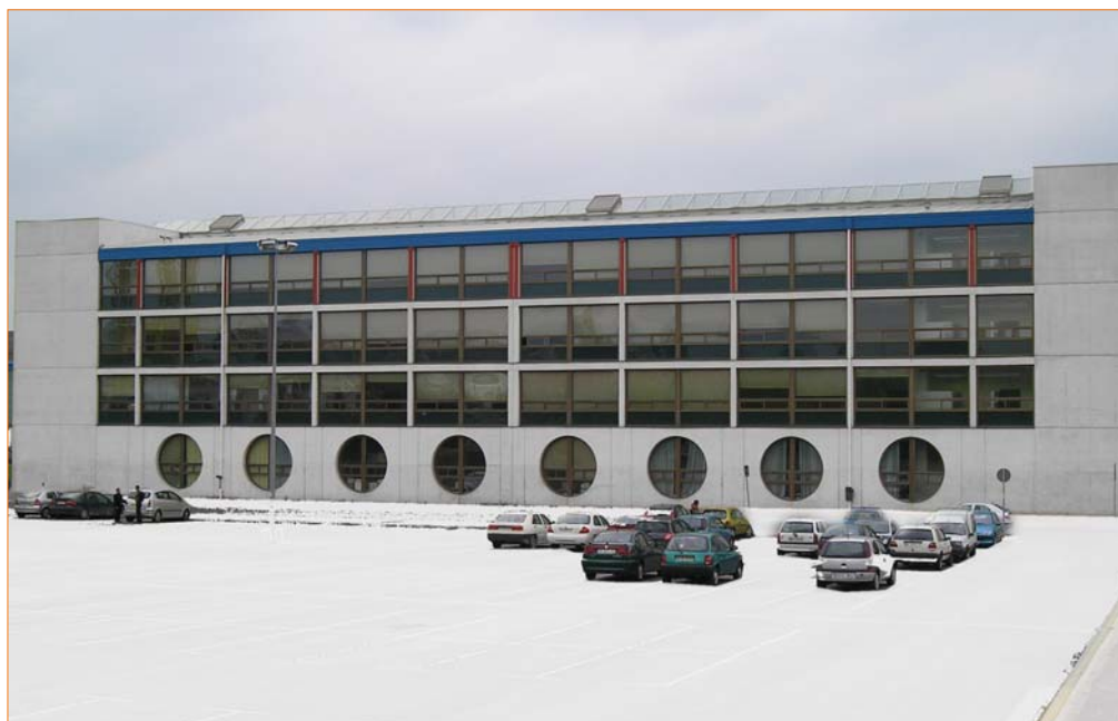
Edificio del Aulario de la Universidad Pública de Navarra
